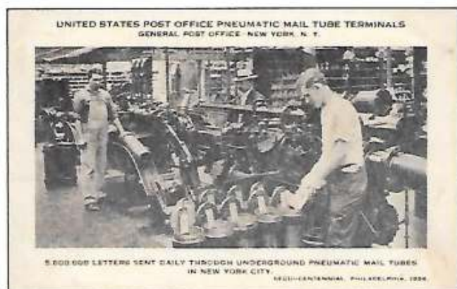
Ansichtkaart uit 1926 met de buizenpost-terminal van het hoofdpstkantoor van New York. De man op de voorgrond doet brieven in de canisters. Bron: ebay.com
